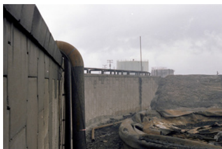
Tras el incendio del depósito de petróleo - Tacoa (Venezuela)
