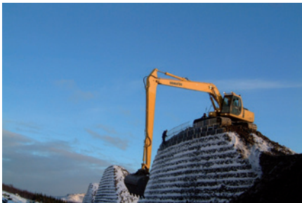
Barrera para avalanchas en Neskaupstadir (Islandia)
