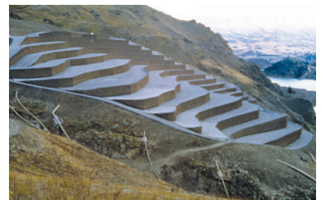
Estabilización de corrimientos de tierra en Cairnmuir (Nueva Zelanda)
