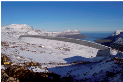
Barreras para avalanchas en Isafjörður y Seydisfjörður (Islandia)
