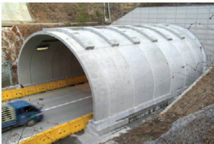
Ampliación de un túnel en Hyeongok (Corea del Sur)
