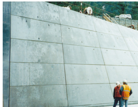
Túnel del segundo canal de descarga de Manapouri, Nueva Zelanda
